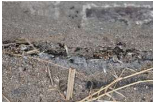
Abb. 5 - Fuge zwischen Gehweg und Mauer
