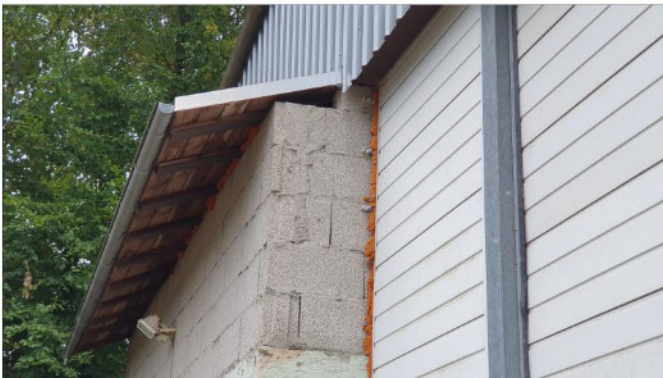
Fassadendetail der Lagerhalle
