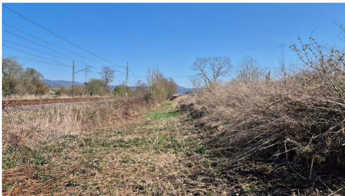
Abbildung 7: Korridor der freigeschnittenen Gasleitungstrasse entlang der Nordseite des UG mit lückig stehenden Feldgehölzen
