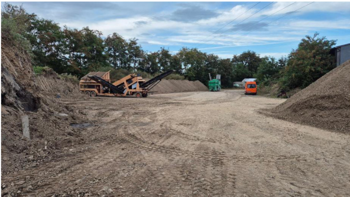
Abbildung 3: Blick auf den östlichen Bereich des UG im September 2025
