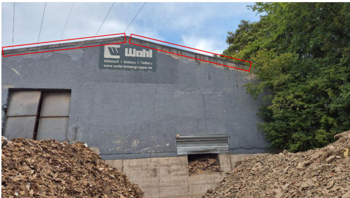
Abbildung 19: Quartierpotenziale für Fledermäuse (rote Rechtecke) an der Westseite der Werkshalle der Firma Wahl
