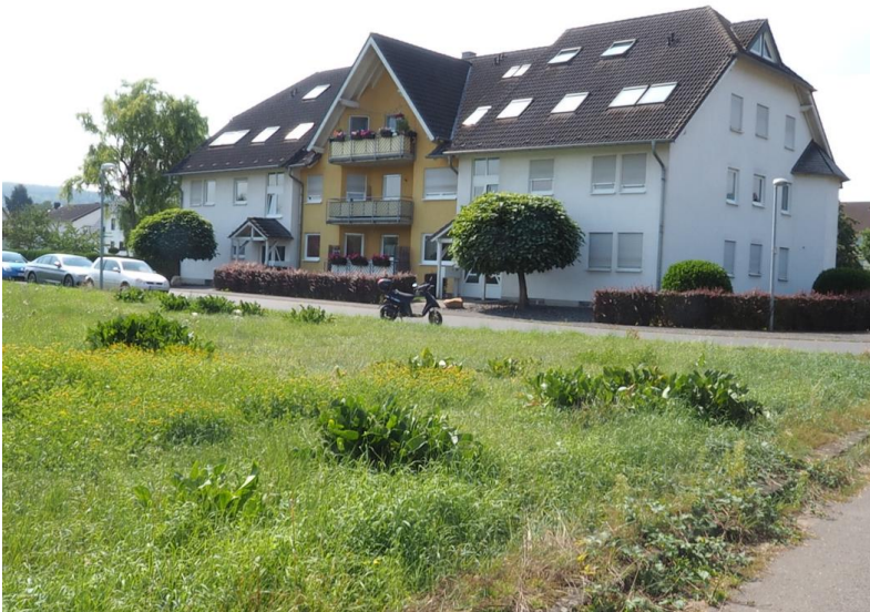
Abbildung 7: Blick aus nördlicher Richtung auf die angrenzende Wohnbebauung mit Erschließung (Weidenweg)
