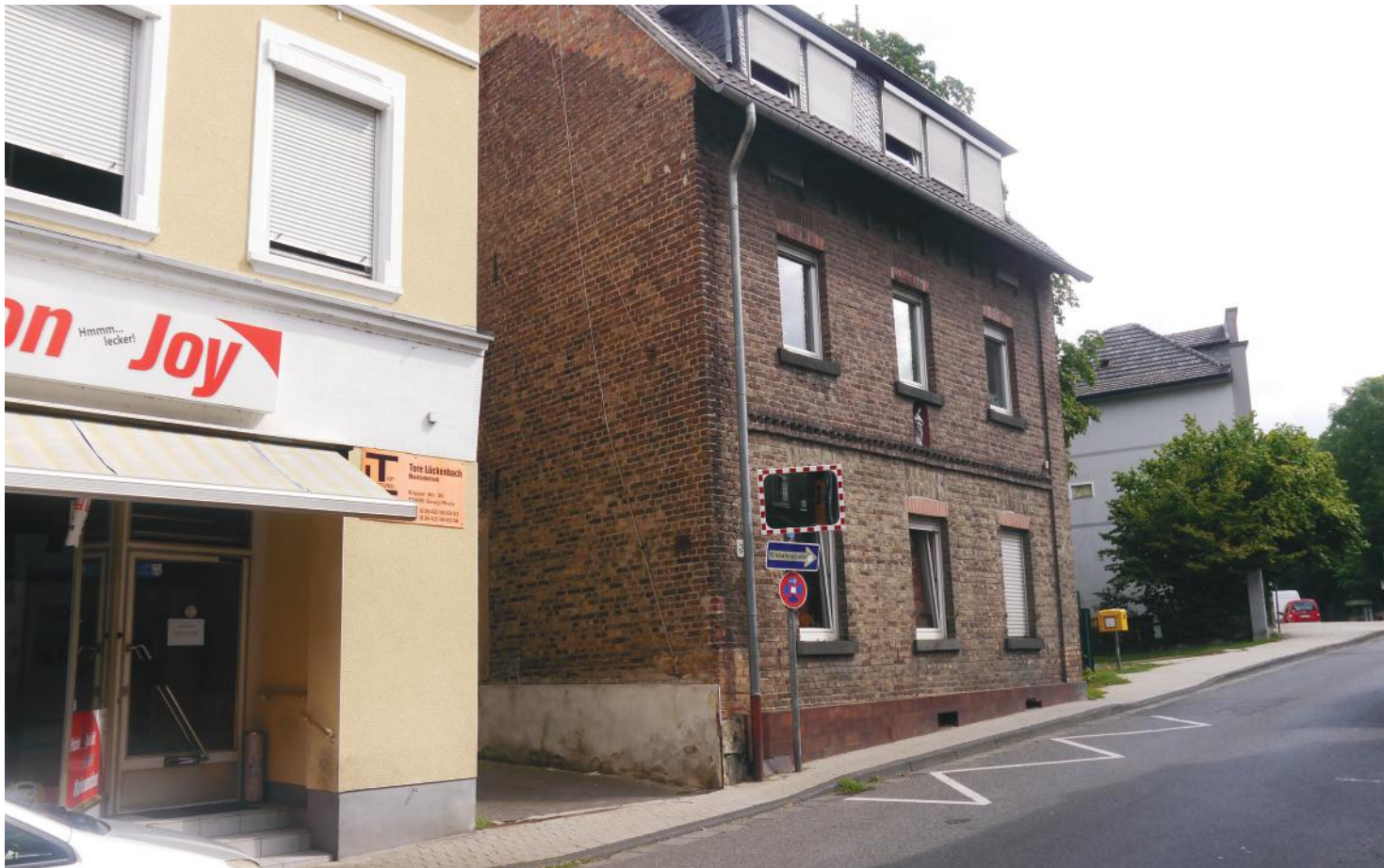
Stellenweise geringe Gehwegbreiten (Koblenzer Straße)
