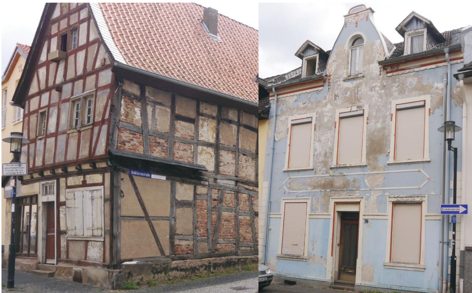
sanierungsbedürftiger Gebäudebestand (Mühlenbachstraße und Ausdorfer Straße)
