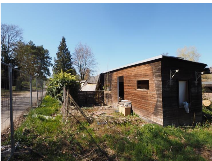
Abbildung 13: Innere Erschließung und Zustand im Plangebiet
