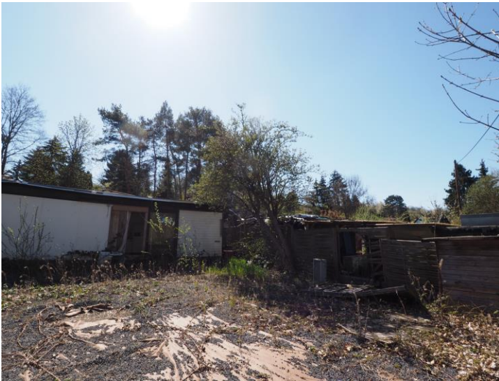
Abbildung 12: Zustand am Zentralgebäude
