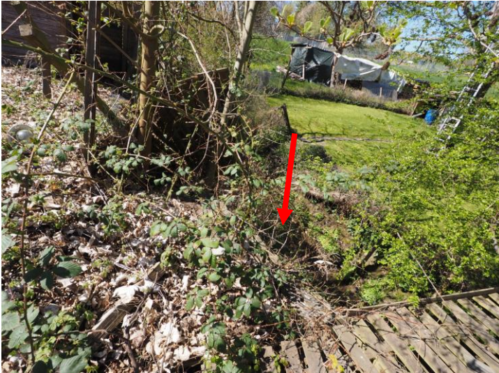
) Abbildung 11: Gewässergraben (Übergang des Plangebietes zum angrenzenden Wohngebiet)
