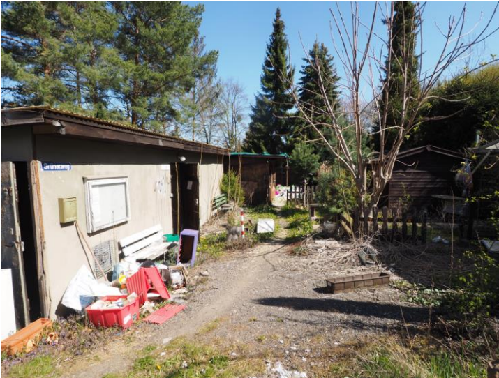
Abbildung 8: Zustand der Stellplätze im Plangebiet
