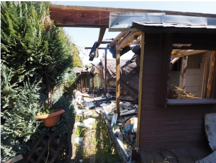
Abbildung 9: Zustand der Stellplätze im Plangebiet
