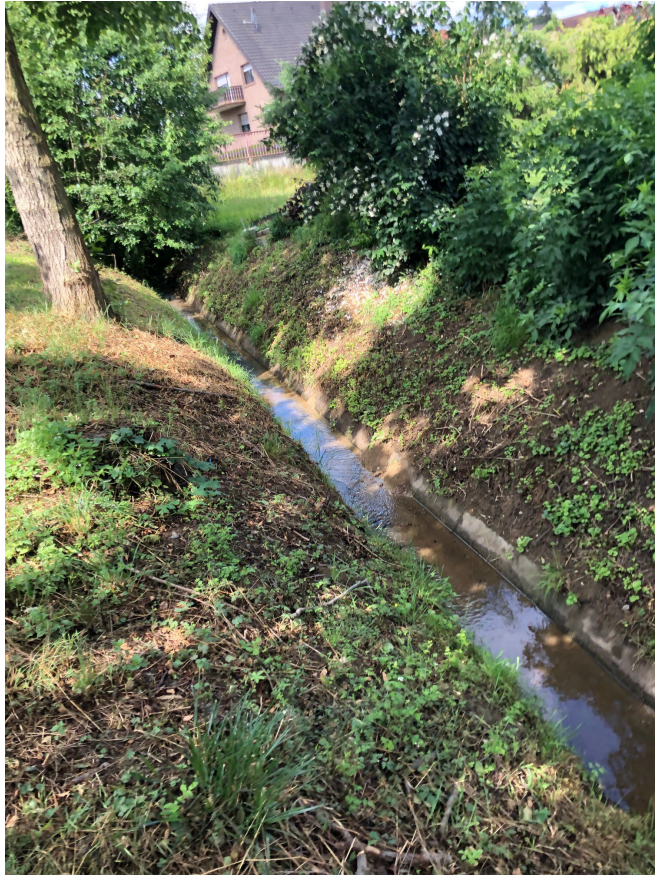
Abb. 22: Uferverbau mit Betonhalbschalen im Bereich Frankenbach im Ortsteil Franken
