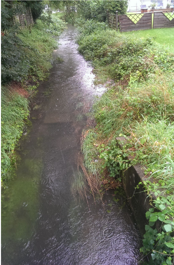
Abb. 23: Sohlverbau im Mühlenbach Ortslage Bad Bodendorf
