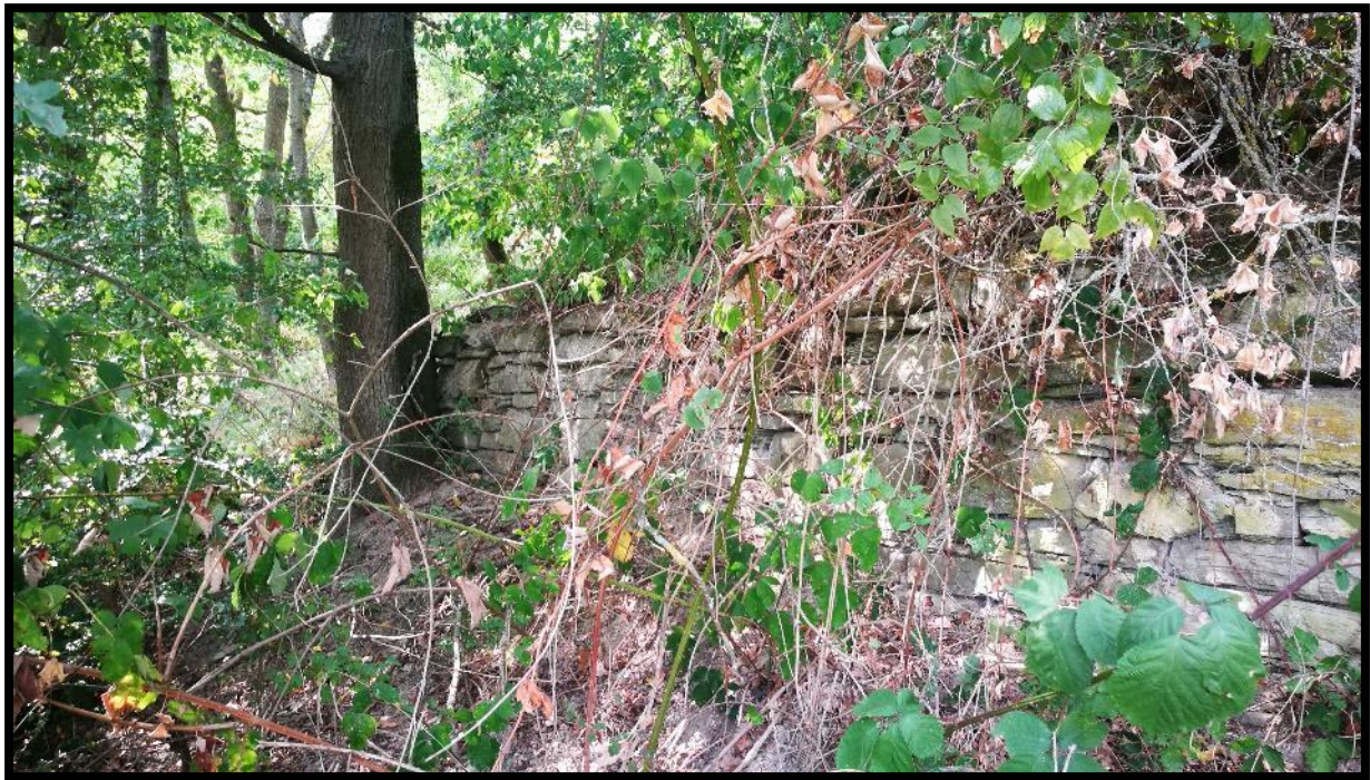
Bild: Stark überwachsene Trockenmauer direkt nordwestlich des PG.
