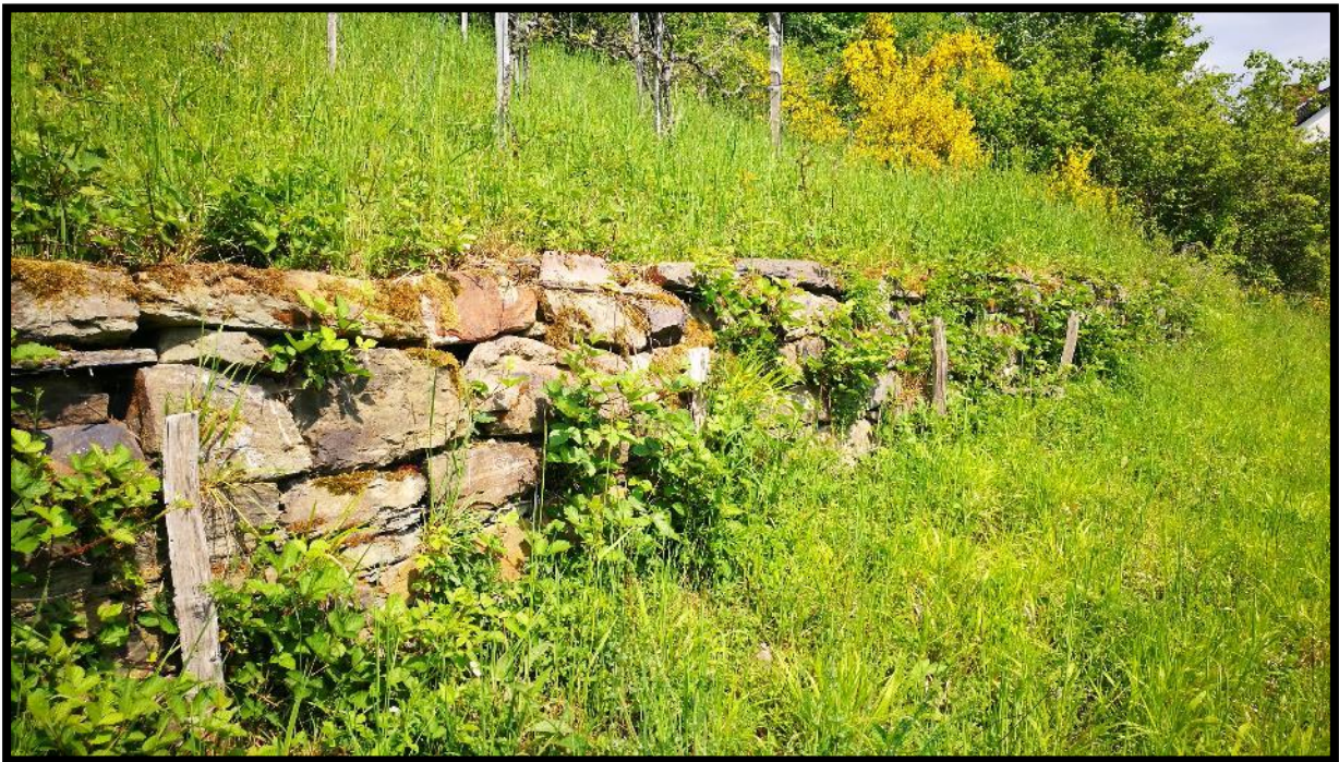
Bild oben: PG mit Blick Richtung Osten. Bild unten: Trockenmauer im PG.
