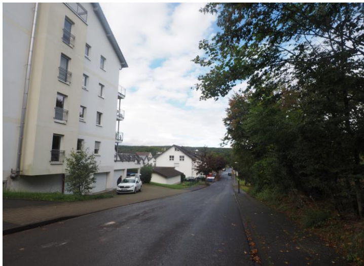
Abbildung 5: Blick in nördliche Richtung entlang der Bäderstraße
