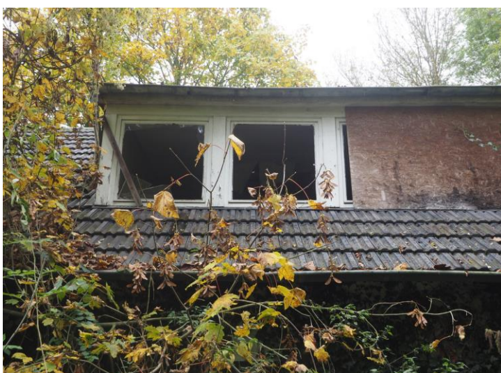
Abbildung 15: Rückseite des Technikgebäudes mit offenen Fenstern, die teilweise abgedeckt sind
