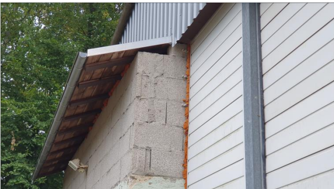
Fassadendetail der Lagerhalle
