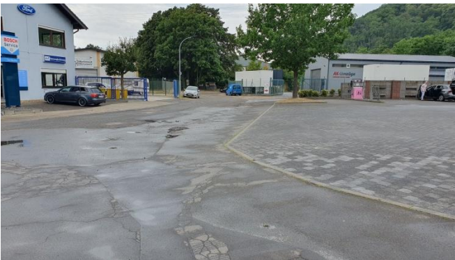
Blick von der Kölner Straße in das Plangebiet
